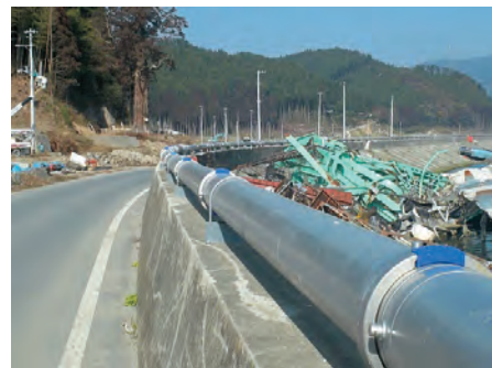
仮設配管レンタル
