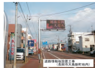
道路情報板設置工事 (長岡市大島新町地内)
