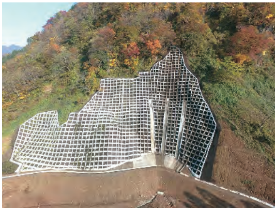
地すべり防止工事
