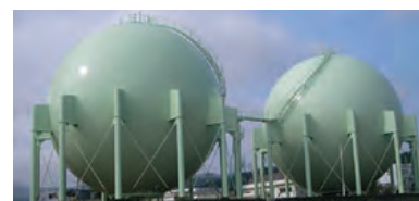
支柱更新工事
