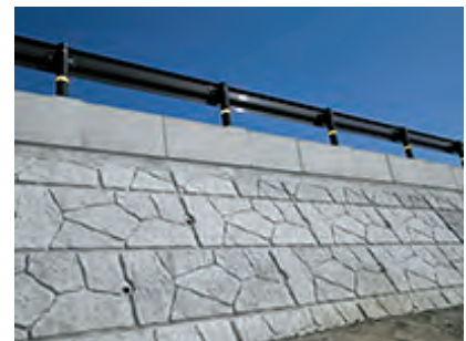
大型積みブロック
